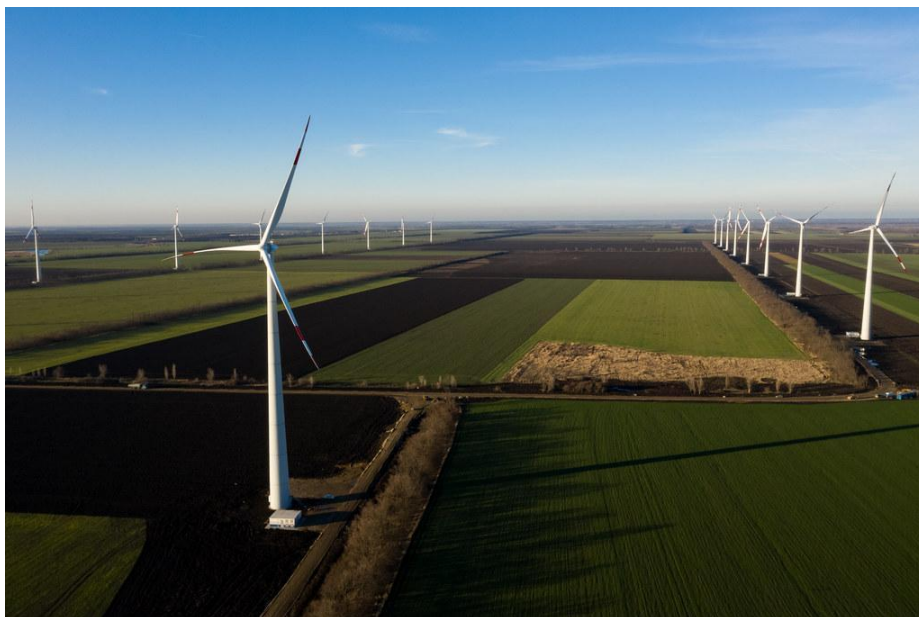
Ставропольский край, Кочубеевская ветроэлектростанция (ВЭС)
